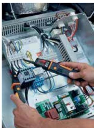
Mesure de tension sur un compresseur.
