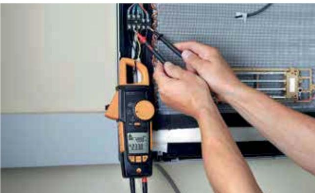
Contrôle de tension sur un système de climatisation avec un **testo 770**.
