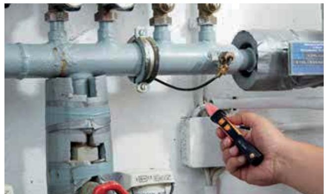
Contrôle de tension sur une boîte de distribution avec un **testo 745**.
