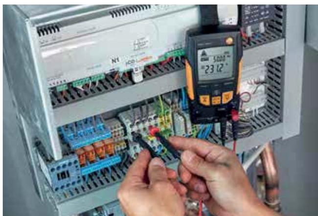
Contrôle de tension sur le tableau de commande d'une pompe à chaleur.
