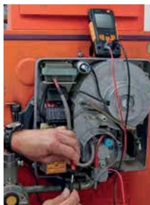
Contrôle de la sonde d'ionisation.
