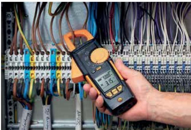
Mesure de courant sur une armoire électrique.
